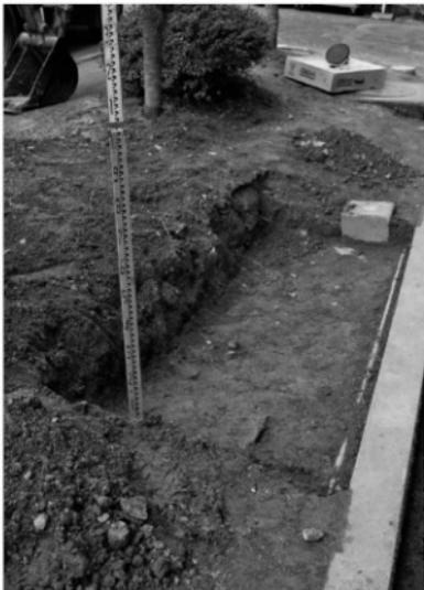
写真4 (城北団地) 評価環境システム納入に伴う空調室外機基礎工事立会
