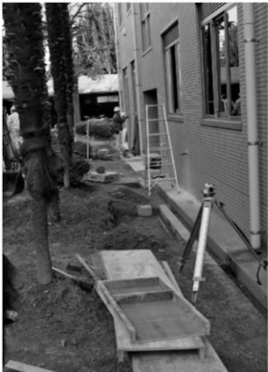
写真3 (城北団地) 評価環境システム納入に伴う空調室外機基礎工事立会
