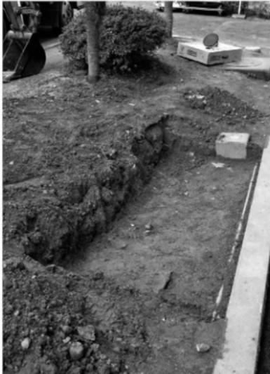
写真5 (城北団地) 評価環境システム納入に伴う空調室外機基礎工事立会
