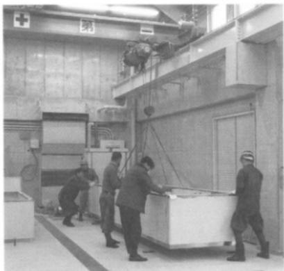
fig. 464 大型PEG含浸槽設置状況
