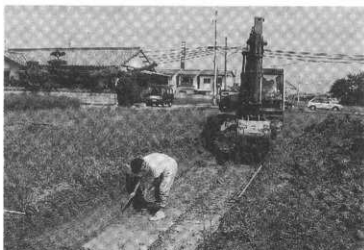
写真22. 2トレ調査風景
