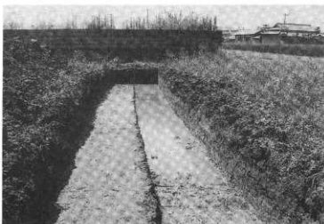
写真23. 3トレ掘削状況
