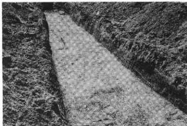
写真51. 1トレ掘削状況
