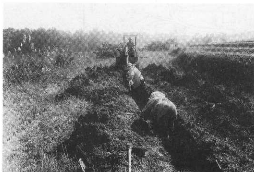
写真39. トレンチ掘削状況
