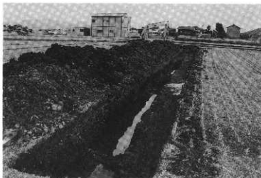
写真35. 7トレ掘削状況
