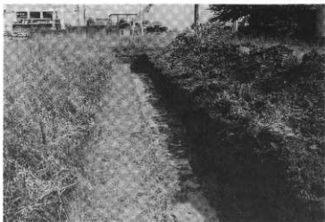
写真21. 1トレ掘削状況
