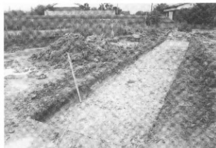
写真14 遠田地区8トレンチ全景
