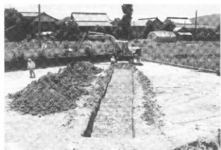
写真29 東原地区23トレンチ全景
