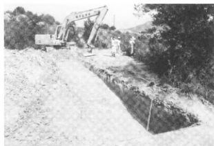
写真7 遠田地区3トレンチ全景
