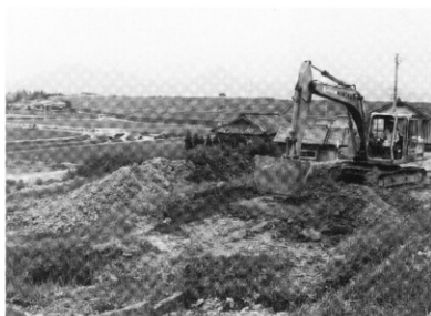
写真 6 5 東原遺跡D区調査前近景
