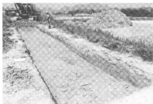
写真21 東原地区16トレンチ全景
