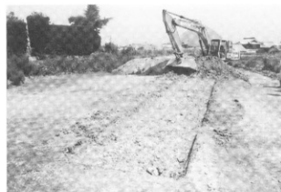
写真18 東原地区12トレンチ全景
