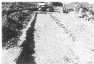
写真27 東原地区21トレンチ遺構検出状況
