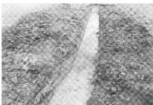
写真38 樋ノ口地区1トレンチ全景
