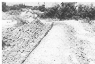
写真5 遠田地区2トレンチ全景
