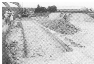
写真17 東原地区11トレンチ全景
