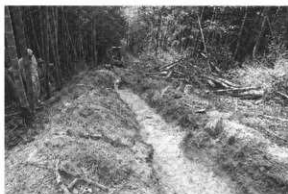
写真52 1トレンチ全景
