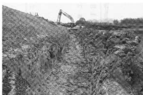
写真48 2トレンチ全景
