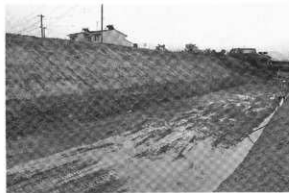
写真50 2 トレンチ全景
