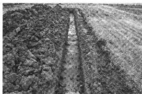
写真45 8トレンチ 全景
