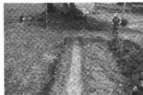
写真42 11トレンチ全景(奥に本村北塚)
