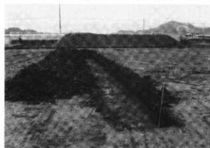
写真77 1トレンチ全景
