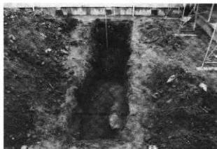
写真63 12トレンチ全景
