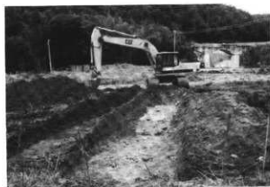
写真75 5トレンチ全景
