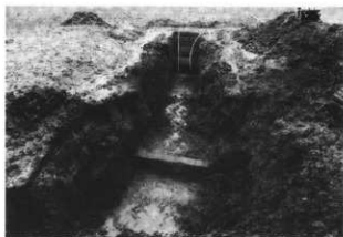
写真35 1トレンチ全景
