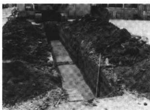
写真4 8トレンチ全景
