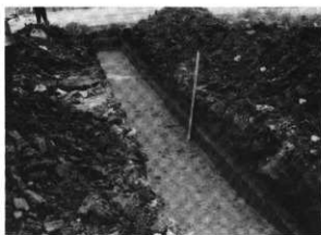
写真3 6トレンチ全景
