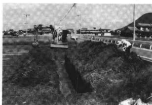
写真45 1トレンチ全景
