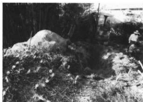
写真15 1トレンチ全景
