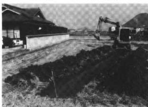
写真46 5トレンチ全景
