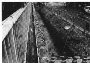
写真48 1トレンチ全景
