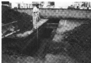
写真54 9トレンチ全景
