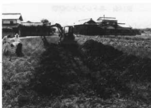
写真47 6トレンチ全景
