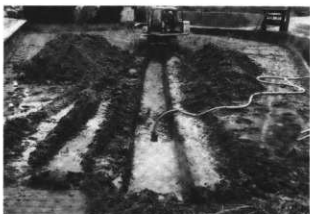
写真37 3トレンチ全景
