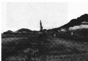
写真43 9トレンチ埋戻し状況
