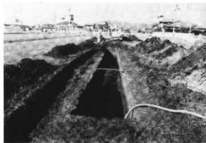
写真38 2トレンチ全景
