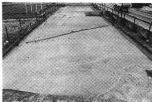
写真14 Ⅱ区全景(西から)
