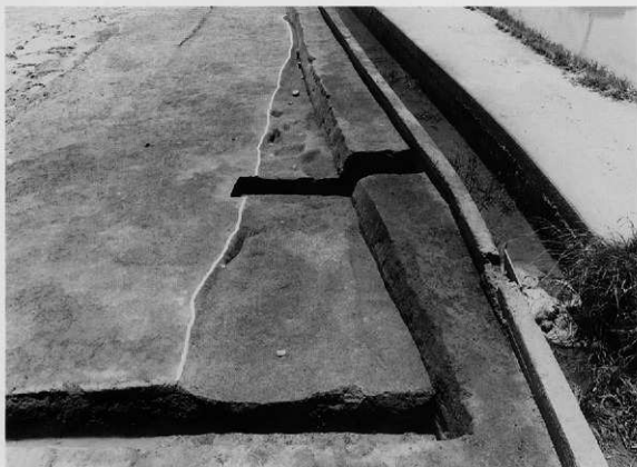
B I 区 SD11掘削状況（北から）
