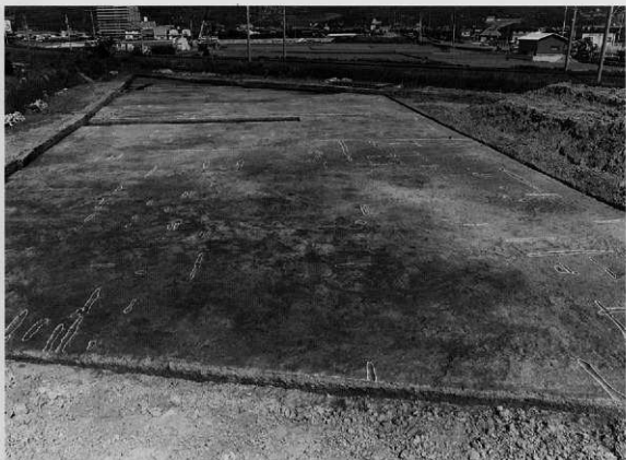
A1区 上層遺構面発掘状況（西から）
