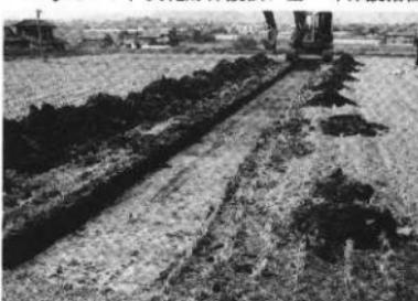
写真45 1トレンチ掘削状況
