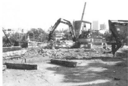
写真20 床面モルタル撤去状況
