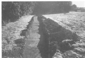
D T 全掘状況
