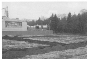
B地区 トレンチ全掘状況
