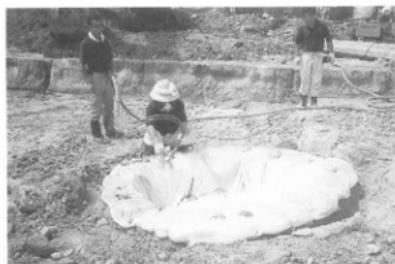
挿図写真3 ビニールフィルムで養生の後硬質発泡ウレタンを充填
