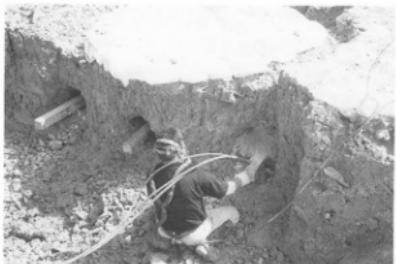
挿図写真5 遺構下部を硬質発泡ウレタンで補強
