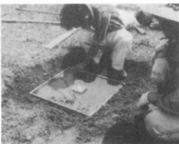
第3図 基準杭設置 (左) 基準点測距 (右) 基準点埋設
