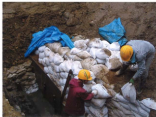
fig27. 石垣の埋め戻し保存
