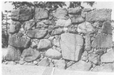
写真 87 石垣復元完了状況（南面）
