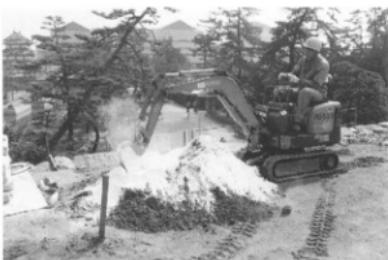
写真 82 天端盛土石灰配合状況（北から）
