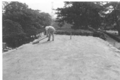
写真 83 天端タタキ仕上げ状況（北から）
