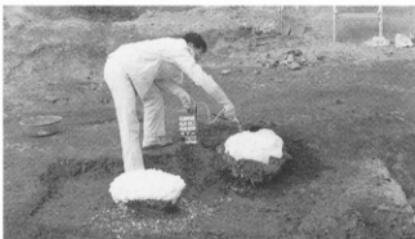
fig. 585 ウレタンフォームの原液を吹きつけ発泡させる
