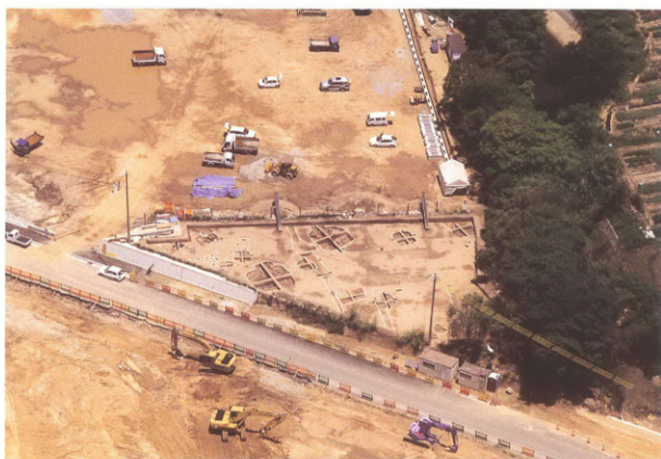
東段丘地区 掘削状況（西上空から）
