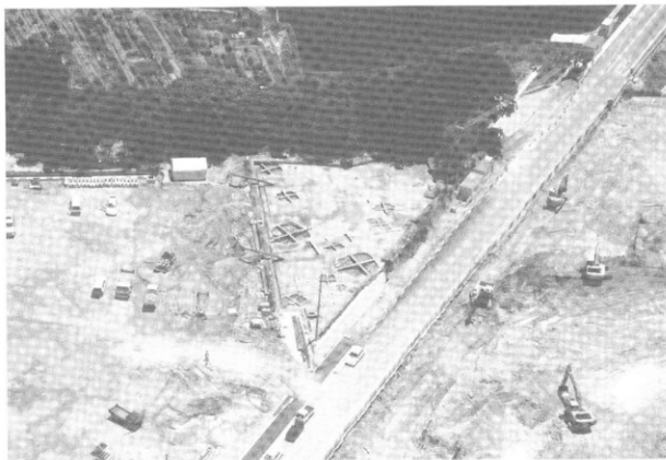
東段丘地区 掘削状況（西北上空から）
