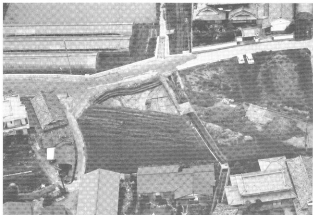
西谷地区 掘削状況 (西南上空から)
