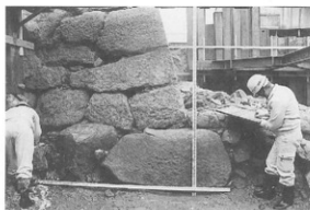
図版5 長槽台石垣基底石(東から)
