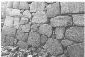
図版10 長槽台石垣北面下部(北から)
