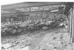
図版8 突堤西面(北より)
