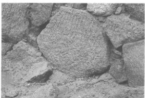
図版11 長槽台石垣北面下部の刻印(北から)
