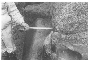
図版6 長槽台石垣基底石の控え部分(北から)
