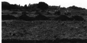
確認調査風景
