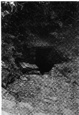
写真7 暗渠の途中に設けられた洗い場（1984年10月撮影）
