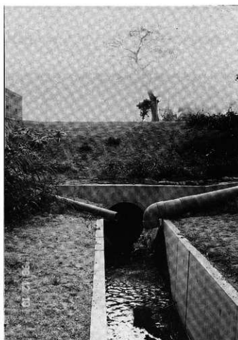
写真10 古水出水の暗渠開口部（1998年12月撮影）
