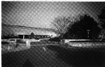
第115図 高松市斎場公園 煙突がなくて火葬場らしく見えない建物となっている。
