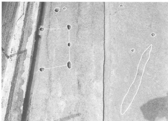
SB17全景 (南より)
