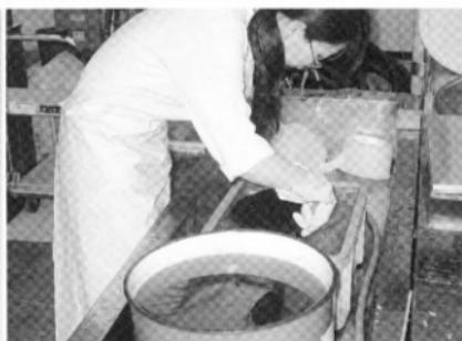
fig. 326 P E G含浸後水洗作業
