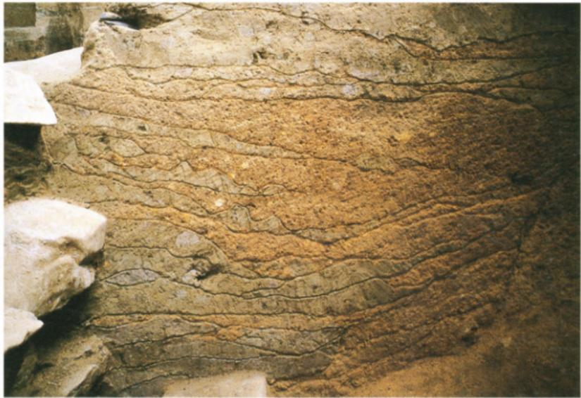
第6図 横穴式石室壁内での防水層（褐色粘土と褐色土の互層）
