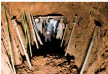
作業風景3(坑道天井の補強)
