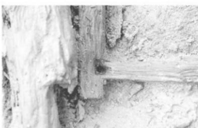
木枠の北材と南材の組み合わせ（上が東）
