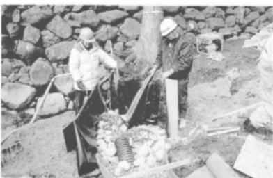
湧水部の玉石導水路施工状況（北から）
