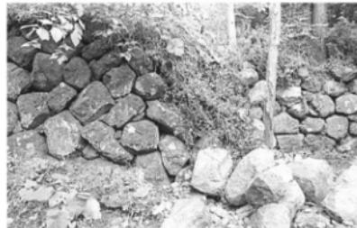
第12図 中門跡石垣の被災状況（北から）
