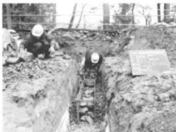
第173図 水平排水溝の玉石敷設（東から）
