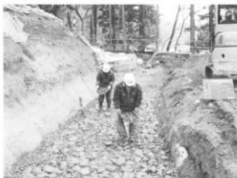
第174図 玉石による基礎補強（東から）
