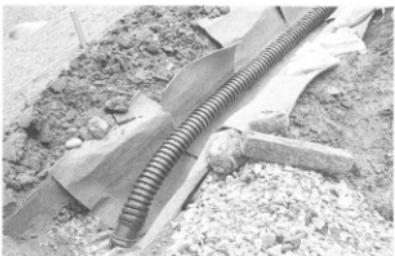
既設管と有孔管の接続状況（西から）
