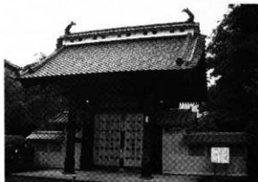
●修理が終了した泰心院山門
