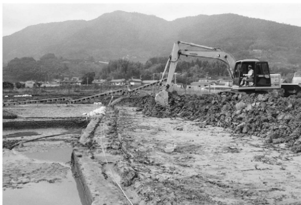
1B区機械掘削状況
