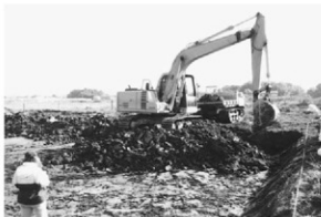
1D区機械掘削状況（北より）
