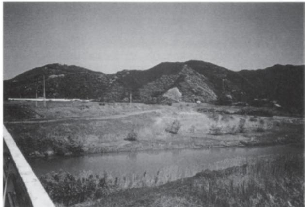
写真－3 現堤防の外側にも自然堤防の一部が存在する
