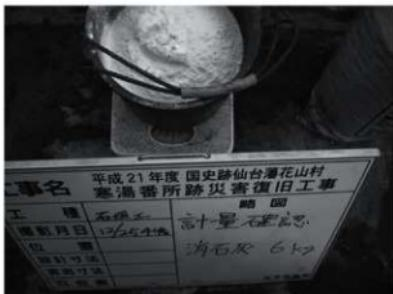
外構 表門臨石垣 7, 8 中込材配合 消石灰 6kg
