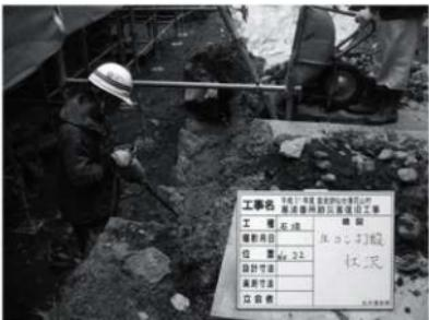
外構 石垣22 石積状況 裏込めコンクリート打設
