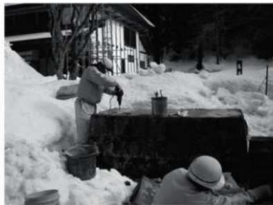
外構 標柱9、10 標柱部取付 ステンレスダボピン施工
