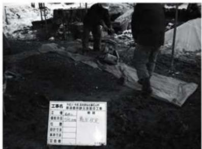
外構 表門脇石垣7、8 中込材配合 振拌転圧状況
