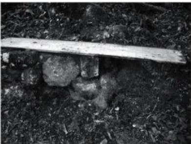
外構 石垣20 石積補修 裏込めコンクリート打設
