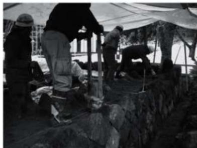
外構 表門脇石垣 8 石積中込突き固め状況
