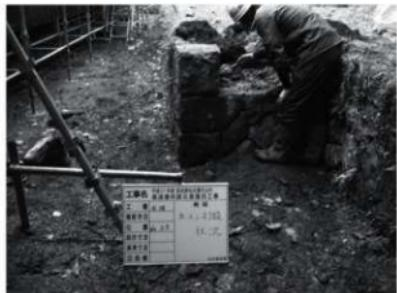
外構 石垣23 石積状況 裏込めコンクリート打設
