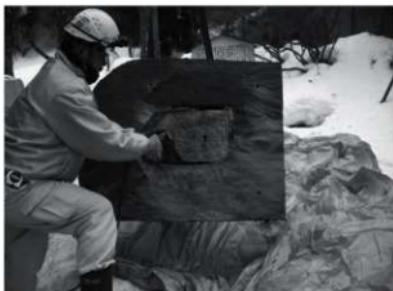
外構 標柱 6 ステンレスダボピン施工
