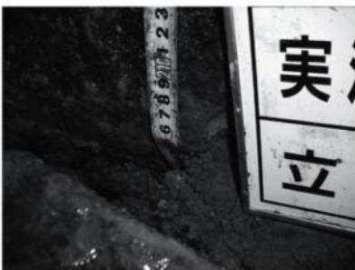
外構 表門脇石垣7 石積中込状況 転圧突き固め管理
