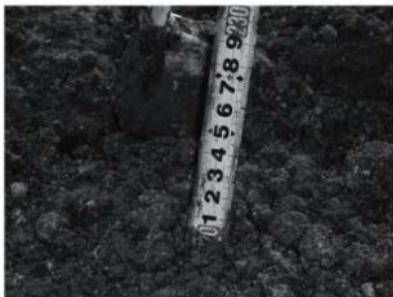
外構 表門脇石垣8 石積中込状況 転圧突き固め管理
