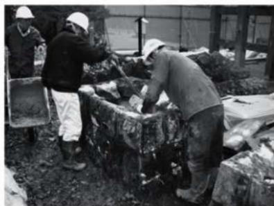
外構 標柱9、10 架台石積 裏込めコンクリート打設
