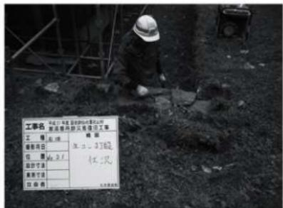
外構 石垣21 石積状況 裏込めコンクリート打設
