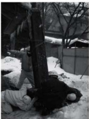
外構 標柱6 接着剤塗布 吊込取付状況
