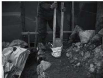
外構 表門脇石垣 7 石積 中込突き固め状況
