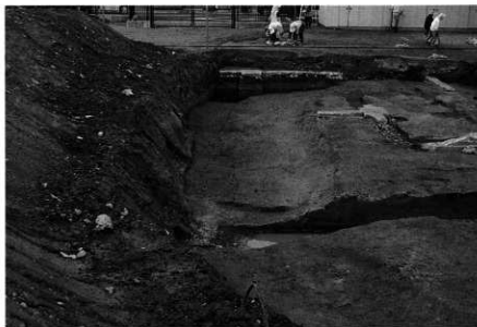
3 西側墳端部検出状況①(南から)
