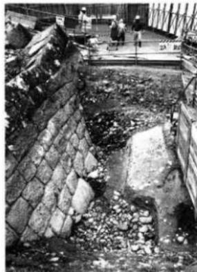
第20図 B面基部 根切り・根石設置状況（東から）
