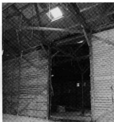
No.11 2号倉庫内壁解体状況(内壁の下地と筋かい)
