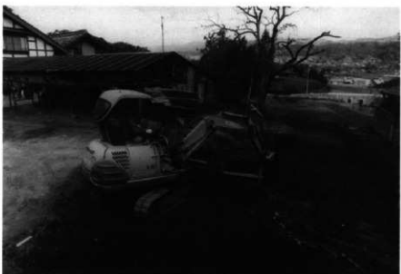
重機作業風景
