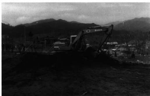
重機作業風景
