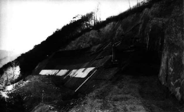
盛土工事 幅約100m、高さ約30mの崩壊地に約7,400㎡の盛土を行った。 (西から)
