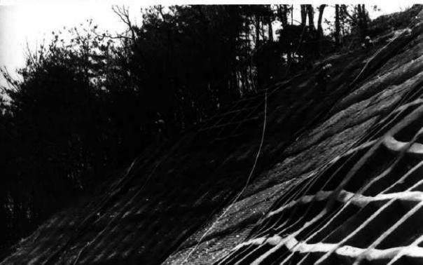
法枠工事 盛土後、コンクリート法枠を打設し、種子吹付けを行った。 (西から)
