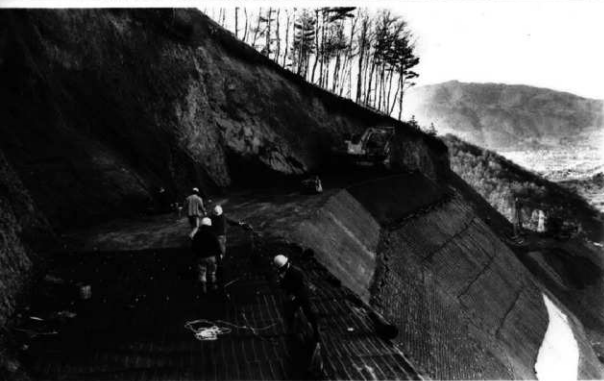
盛土補強材敷設 盛土高2.4m毎に樹脂製の補強材、1.2m毎に排水材を敷設した。 (東から)
