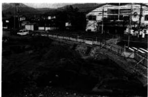
B区全景 (南から)
