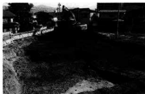
B区表土除去
