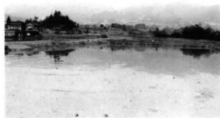
東から 工事後
