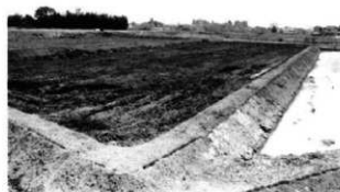
南西から 工事後
