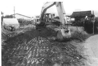
重機による表土剥ぎ
