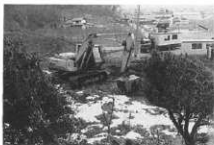
第197図 表土掘削状況
