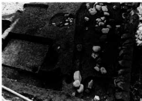
写真25 土蔵根石・地下室底面
