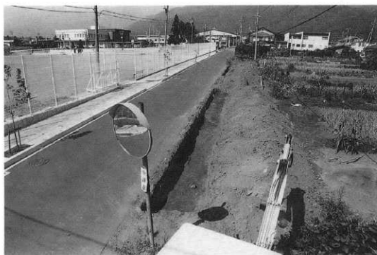
南側調査状況
