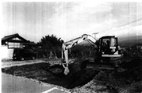
重機作業風景
