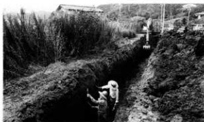
D地区 試掘坑
