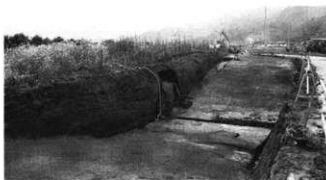
大溝・北（北東から）
