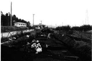
B地区遺構検出（南から）
