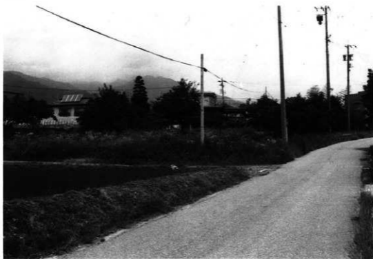
DUG VII調査前（南から）
