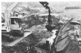
第6図 クラムシェルによる試掘
