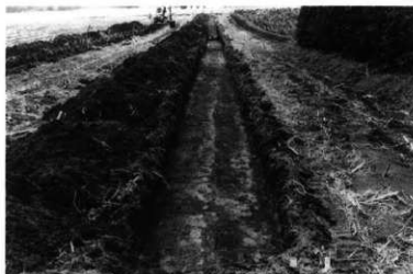
AH-2 トレンチ
