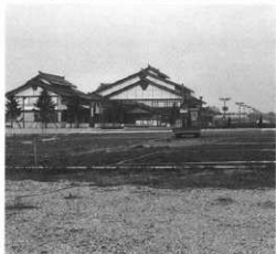
中久保田遺跡1調査地点近景（南方から）
