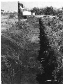
中原道跡群5トレンチ（南方から）
