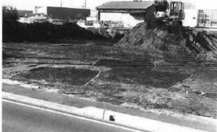
西赤座遺跡 8 グランド用地遺構検出状況 (南東方から)
