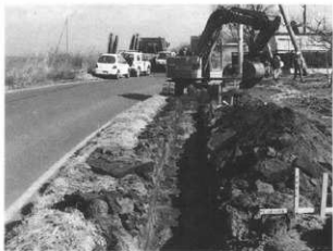
西大久保遺跡群2調査地点近景 (南方から)
