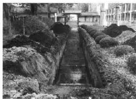
高師町遺跡群 2 E トレンチ (東方から)
