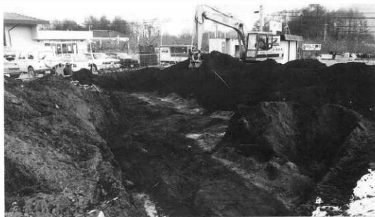
栗毛坂遺跡群13遺構検出状況 (南西方から)
