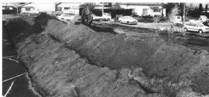
上の城道跡群5調査地点近景（東方から）
