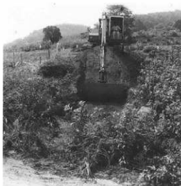
榛名平遺跡調査地点近景 (北方から)
