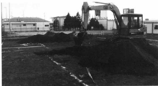
中久保田道路1調査地点近景（西方から）
