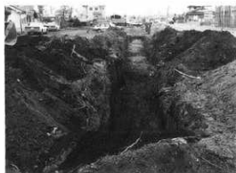
高師町遺跡群 2 A トレンチ (東方から)
