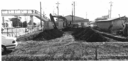
岩村田遺跡群11調査地点近景 (西方から)
